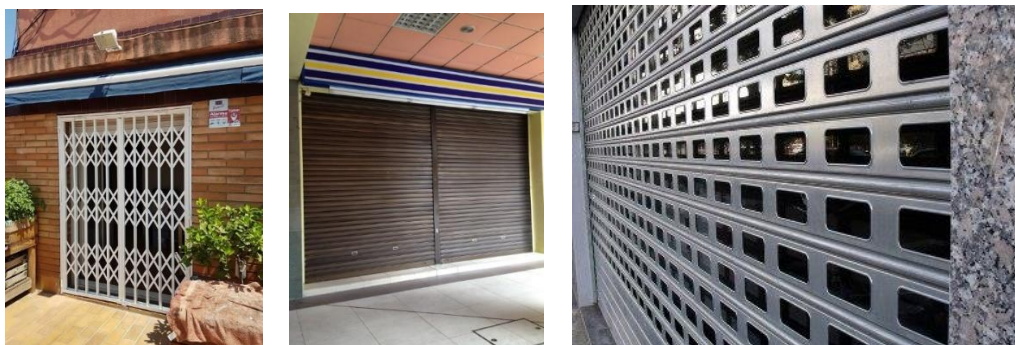
Figura 20. Cierres metálicos. De izquierda a derecha: tijera, enrollable ciego y enrollable con visibilidad. Fuente: CBCM
