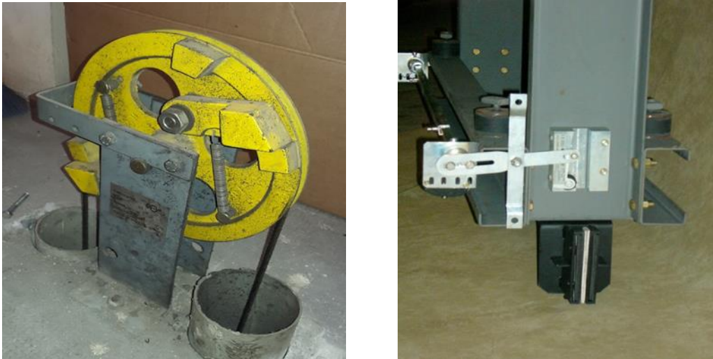
Figura 8. Limitador de velocidad centrífugo; y sistema paracaídas o cuñas. Fuente: CBCM
